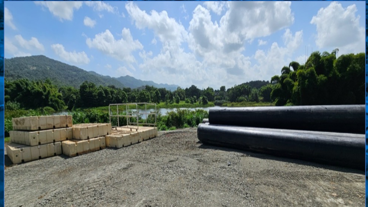
Carraízo Dredging $88 M
