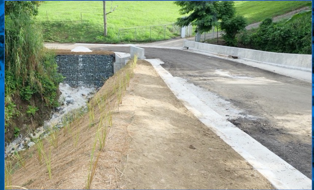
Puente Los Muros Final, Aibonito $1.1 M
