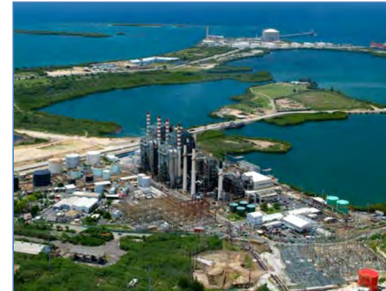
Aerial Pictures Costa Sur
